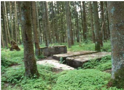
Massive Fundamente mit Ausparungen, Eisenbolzen und einem beckenartigen Aufbau an der südlichen Längsseite der großen Montagehalle bilden Befund 21 (Transformator). Foto: O. Kraus.
