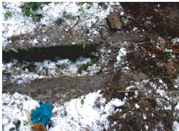
Freigelegte Fundamente im Innern der großen Montagehalle (Befund 1). Foto: O. Kraus.
