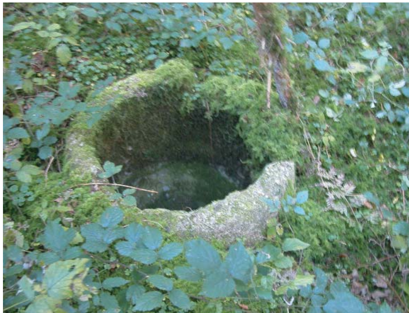
Revisionsschacht Befund 23. Foto: G. Mahnkopf.
