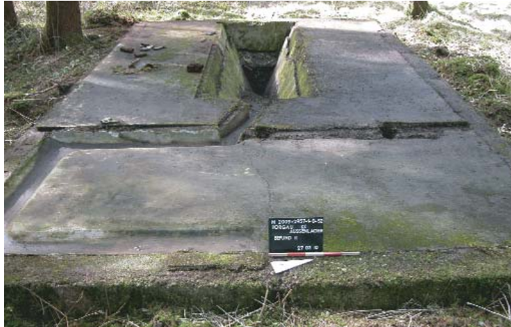
Befund 11 ist eine Bodenplatte mit tiefer Wanne, Rinnen und Aussparungen für die Entwässerung. Foto: M. Bistrizki.
