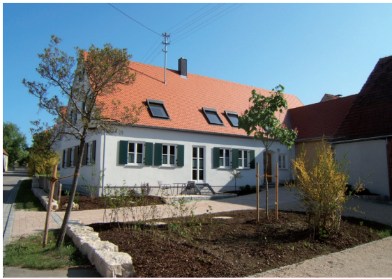
◆ Forheim, Lkr. Donau-Ries - Dorfgerechter Ersatzbau in Holzbauweise
