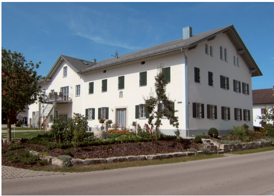
◆ Seuersholz, Lkr. Eichstätt - Sanierung eines Bauernhofes mit Umnutzung des Wirtschaftsteiles
