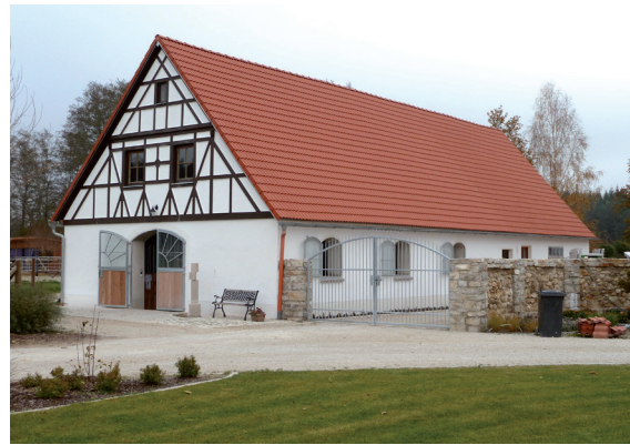
◆ Huisheim, Lkr. Donau-Ries - Umbau eines maroden Nebengebäudes zu privaten Pferdestallungen
