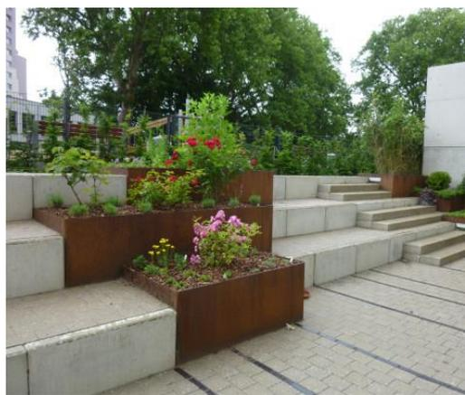
*Abb. 4. Beispiel Sitzstufen mit Pflanzbeeten aus Cortenstahl (eigenes Foto)*
